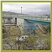
Imagen del sitio Image of installation site
