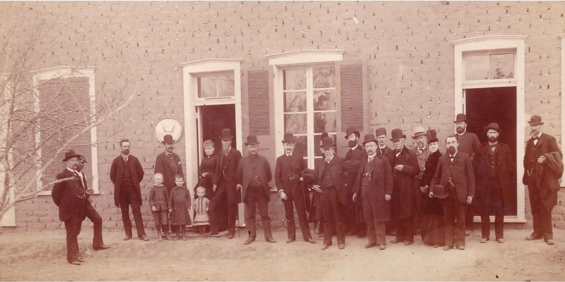
United States Consulate in Paso del Norte (Circa 1880). Adobe building with wood and glass windows. Photo ELPHS. Consulado de Estados Unidos en Paso del Norte (Circa 1880). Edificio de adobe con ventanales de madera y vidrio. Foto ELPHS.
